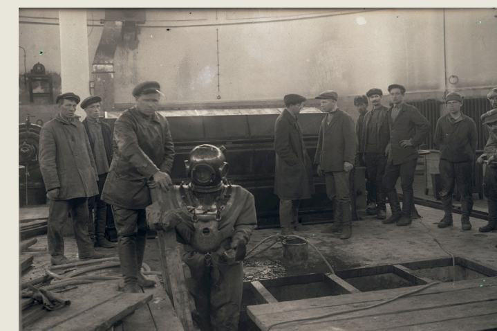
Водолазные работы в насосной станции 14 мая 1933 года.
